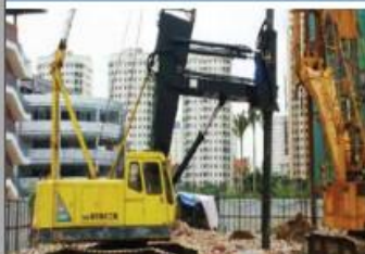
Dây chuyền khoan cọc nhồi CX500 Lines of bored pile CX500
