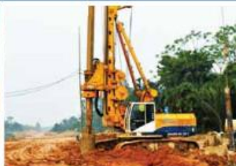
Dây chuyền khoan cọc nhồi BAUER BG25 Lines of bored pile BAUER BG25
