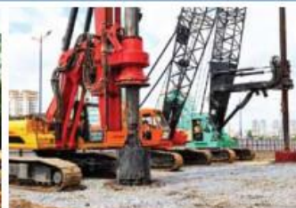
Dây chuyền khoan cọc nhồi SH655 Lines of bored pile SH655
